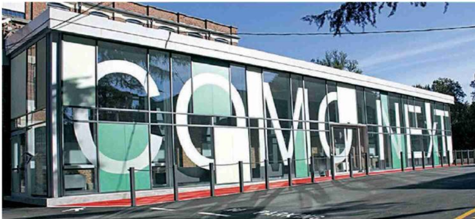
Una delle strutture che compongono ComoNext, polo di innovazione tecnologica e incubatore di startup che opera fin dal 2010 all'interno dell'antico Cotonificio Somaini a Lomazzo, sorto a fine Ottocento accanto alla stazione ferroviaria
